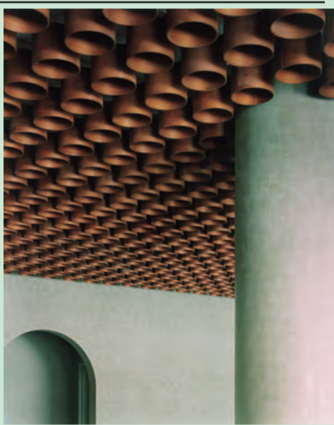
2階ホールの、曲げわっぱの天井！ 写真：瀧本祥也
